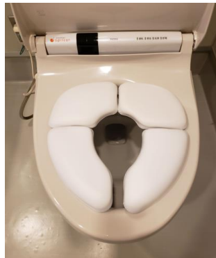
公民館多目的トイレ お子様用補助便座
